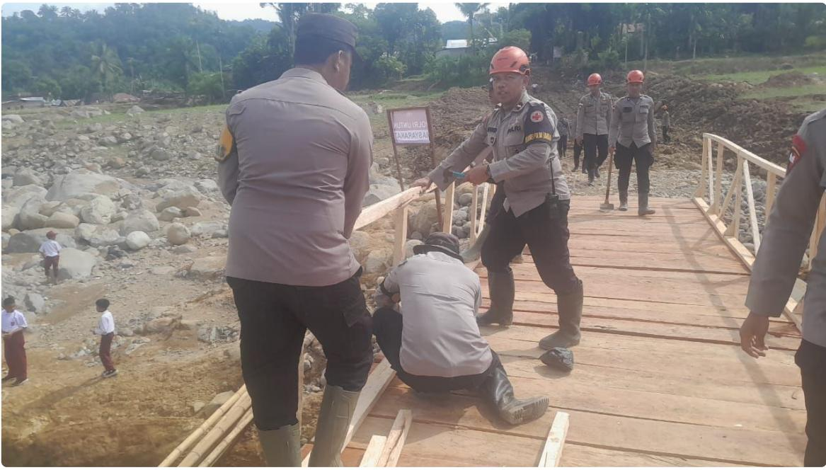
Kegiatan dimulai sekitar pukul 10.00 WIB dan difokuskan pada tahap pemasangan pagar jembatan yang telah rampung, yang dilanjutkan dengan perapihan area sekitar jembatan.
